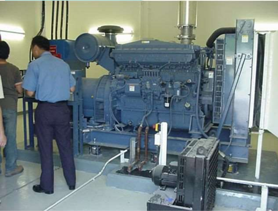
390千瓦消防柴油发电机 390KVA Fire Service Generator
